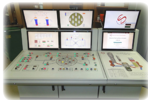
تصویر میز کنترل دستگاه
